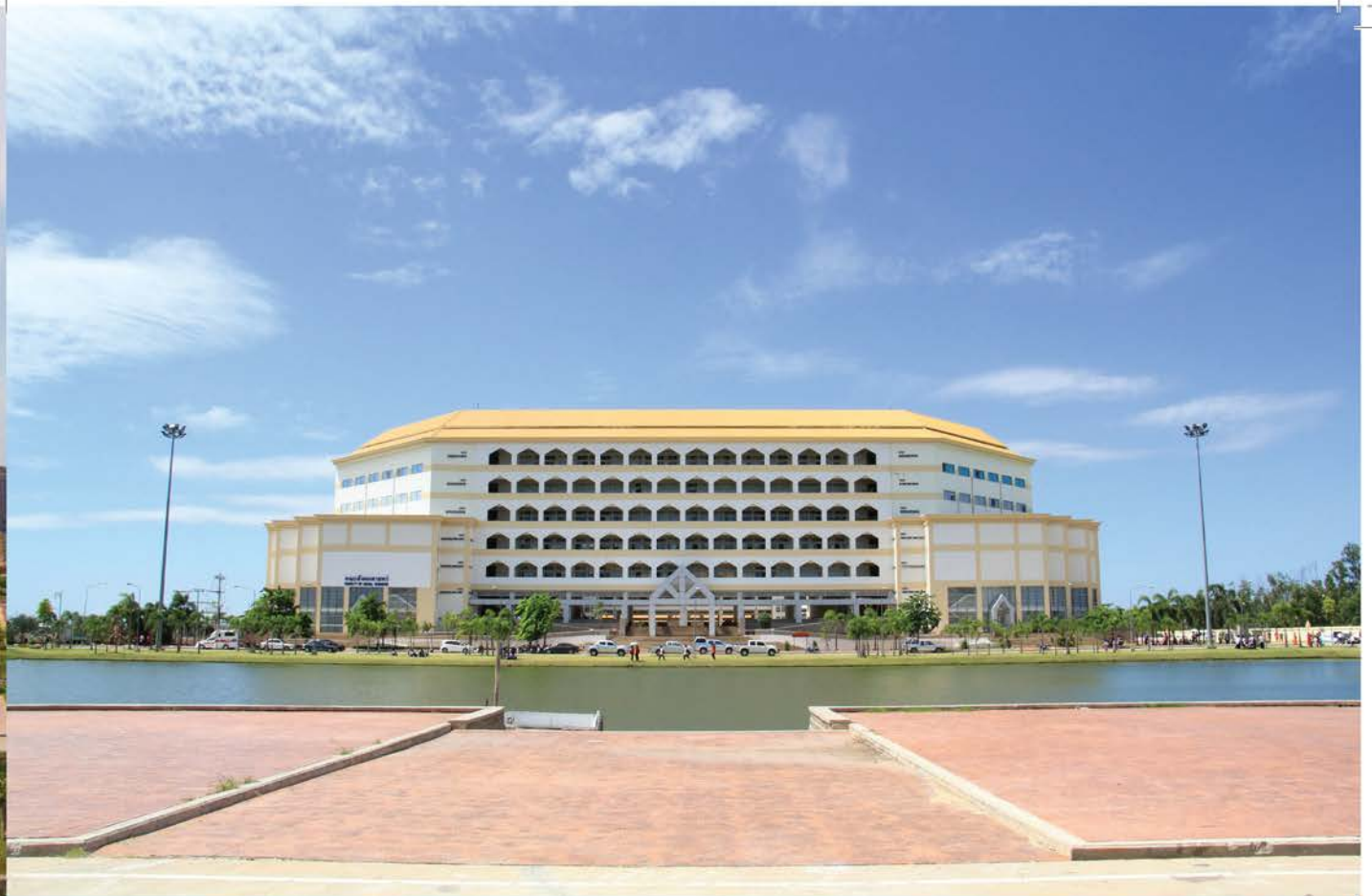
อาคารเรียนรวมและอุโบสถกลางน้ำ
